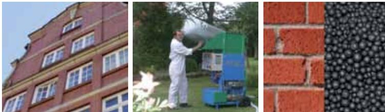
La machine à insuffler souffle le matériau à travers un long tuyau flexible, jusque dans le creux du mur.
