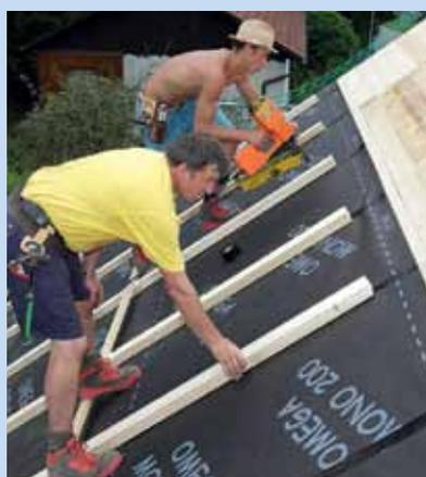
2 | Poser les contre-lattes sur les bandes d'étanchéité pour zone clouée
