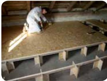
Poser la dalle praticable, p.ex. panneaux dérivés du bois OSB de 18 mm avec rainure et languette.
