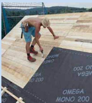
1 | Agraffer la membrane de toit et coller les recouvrements.
