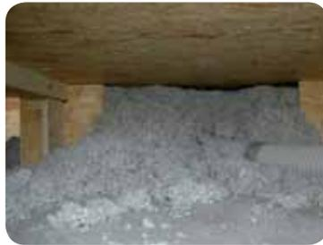
Isolation par injection ISOCELL avec procédé d'insufflation.
